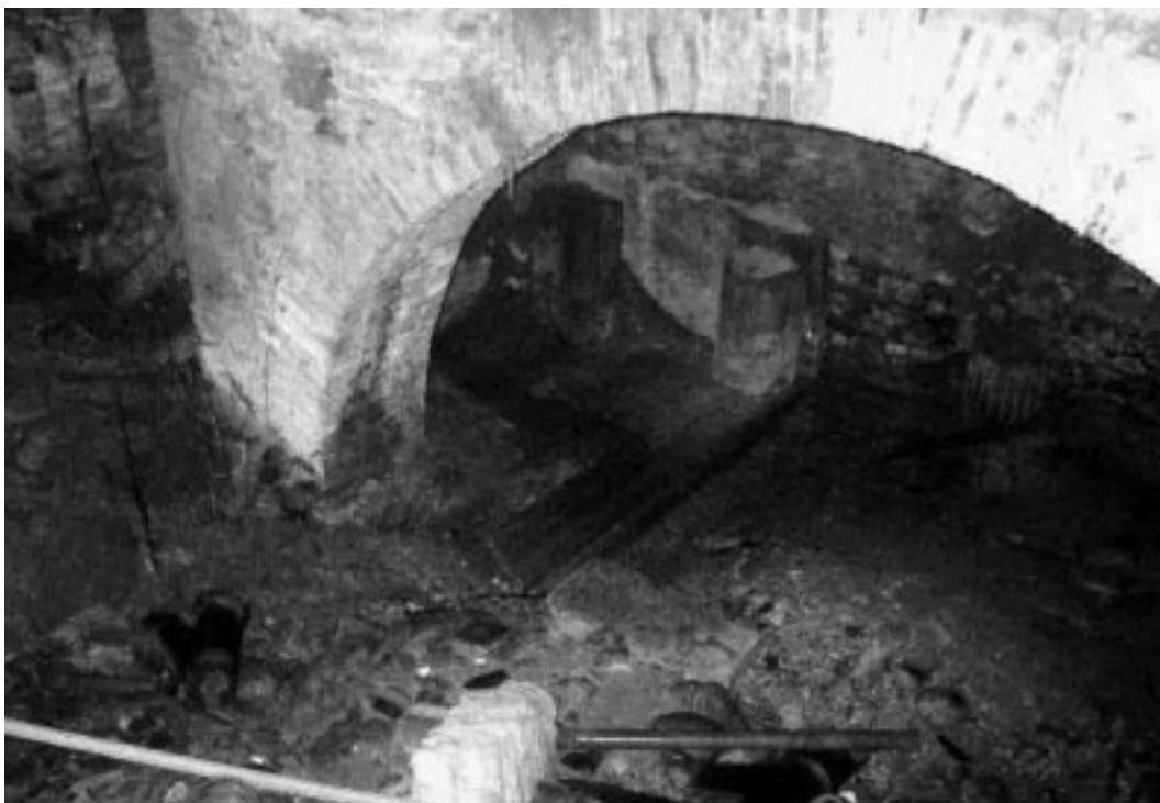
Fig 1 - Resti dell'edificio pubblico romano nei sotterranei dell'ex Convento di San Giovanni
