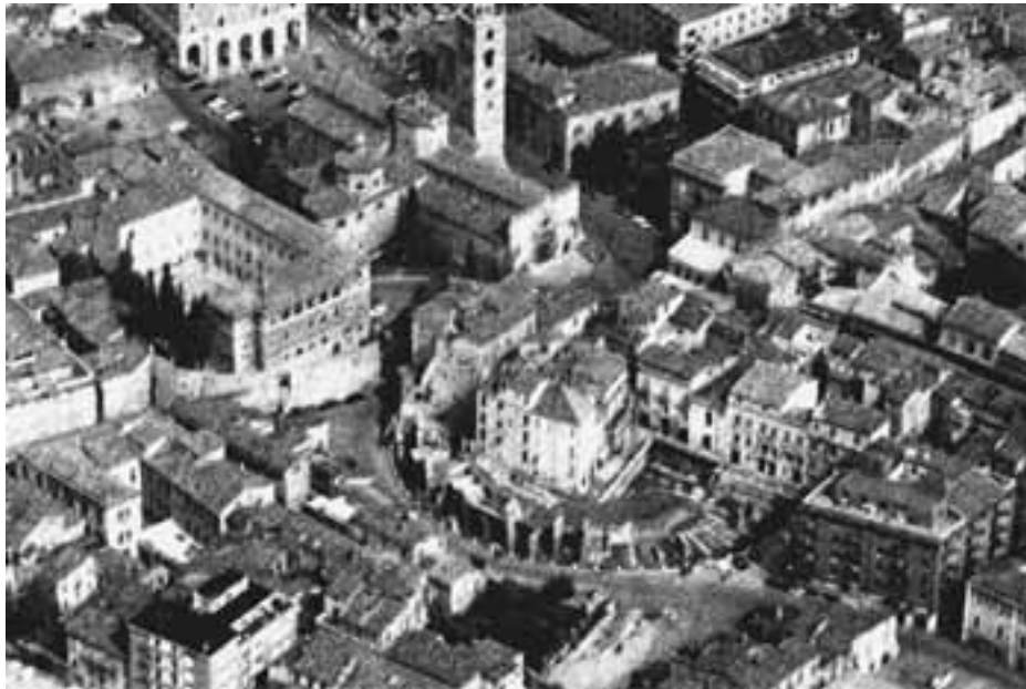
Fig 3 - Teramo 1984, dopo le demolizioni: disfatta l'antica forma, rimangono vuoti urbani irrisolti e macerie
