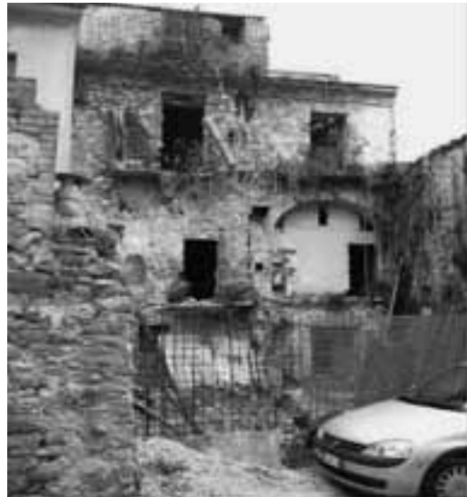
Foto IV- Casa diroccata in angolo fra Vico del Pensiero e Via della Pinacoteca: è adiacente alla storica Chiesa di S.M. a Bitetto, in parte sopravvissuta all'incendio normanno del XII sec.
